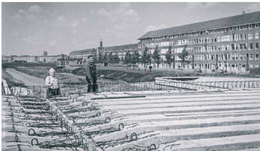
1960: Brug over Westlandgracht in aanbouw, in de achtergrond rechts de Postjeskade.
