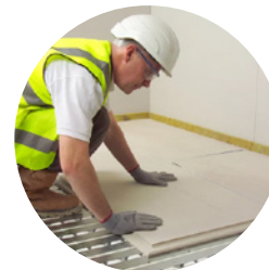
losmaakbare dekvloeren maken demontage mogelijk
